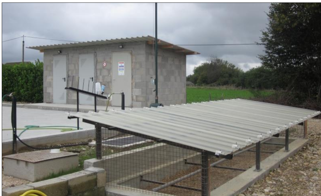
Rys. 36. Stanowisko bioremediacyjne PHYTOBAC z grawitacyjnym spływem wody ze stanowiska do napełniania i mycia opryskiwacza
