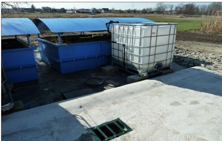
Rys. 11. Naziemny zbiornik buforowy z pompą do nanoszenia płynnych pozostałości na substrat stanowiska bioremediacyjnego
