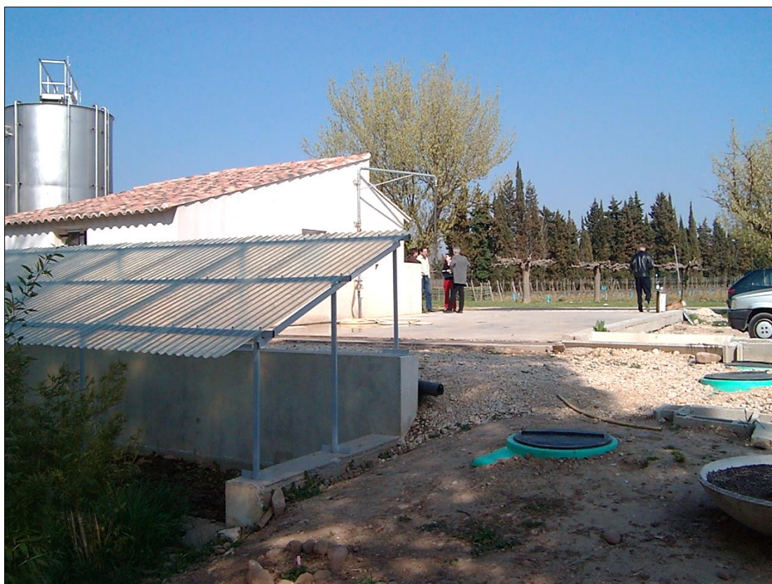
Rys. 37. Stanowisko bioremediacyjne PHYTOBAC z grawitacyjnym spływem wody ze stanowiska do napełniania i mycia opryskiwacza
