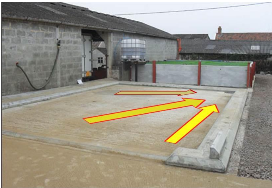
Rys. 2. Obandowana płyta betonowa ze spływem wody do kratki ściekowej
