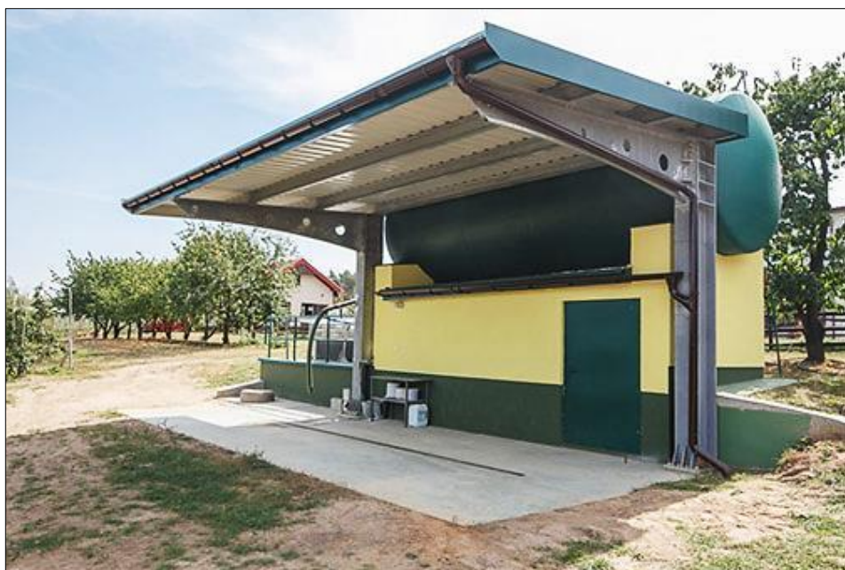
Rys. 3. Zadaszone stanowisko do napełniania i mycia opryskiwacza
