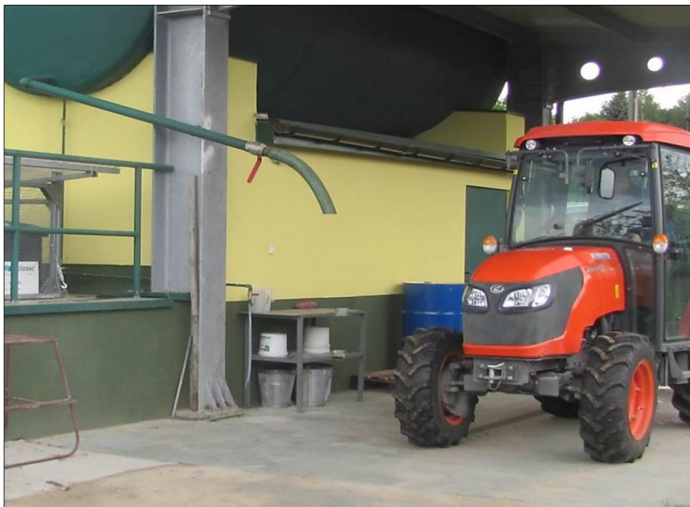
Rys. 5. Miejsce do odmierzania i wstępnego rozładniawania środków ochrony roślin z blatem i ujęciem wody na stanowisku do napełniania i mycia opryskiwacza
