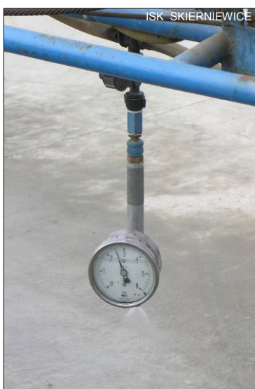
Rys. 17 Ocena spadku ciśnienia w instalacji za pomocą manometru zamontowanego w miejsce rozpylacza
