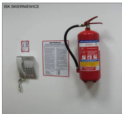
Rys. 12 Gaśnica, instrukcja bhp i telefon przed wejściem do magazynu
