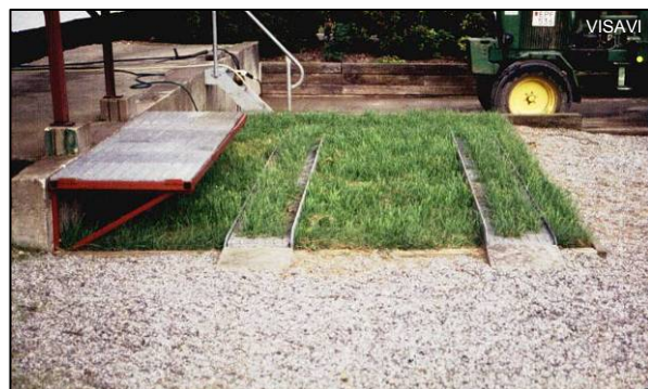
Rys. 31 Stanowisko biobed do napelniania opryskiwacza i przygotowania cieczy użytkowej. Biologiczne podłoże neutralizuje skażenia miejscowe, a odcieki zbierane są do zbiornika
