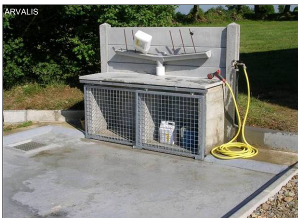
Rys. 30 Bezpieczne miejsce do rozwadniania preparatów w gospodarstwie: utwardzona i nieprzepuszczalna powierzchnia, ujęcie wody, zabezpieczenie przed rozprzestrzenieniem się ciekłych pozostałości, odpływ do zamkniętego systemu zbierania ciekłych pozostałości
