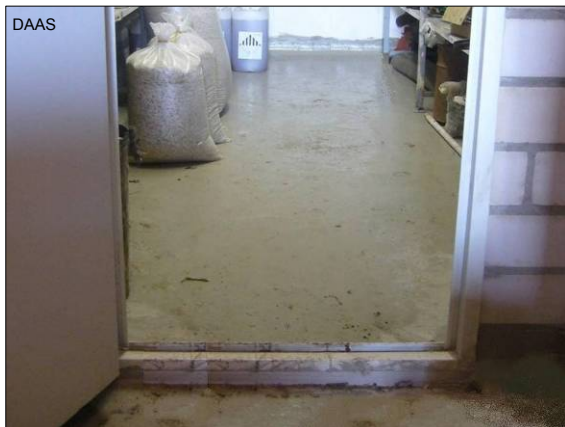
Rys. 9 Wysoki próg zabezpieczający przed rozprzestrzenianiem się wycieków .
