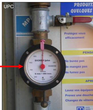
Rys. 28 Przepływomierz na przewodzie zasilającym do precyzyjnego napełniania zbiornika opryskiwacza wodą
