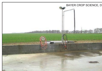
Rys. 13 W gospodarstwie ciecz użytkową należy sporządzać na nieprzepuszczalnym podłożu, umożliwiającym zbieranie zanieczyszczonej wody
